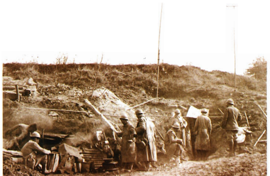
Figure 1. — La Tour Carrée près de Lihons, poste de TSF de réception de l'artillerie à l'écoute de l'avion, on distingue à l'arrière les perches couplées permettant le support de l'antenne horizontale (Collection M. G.).
