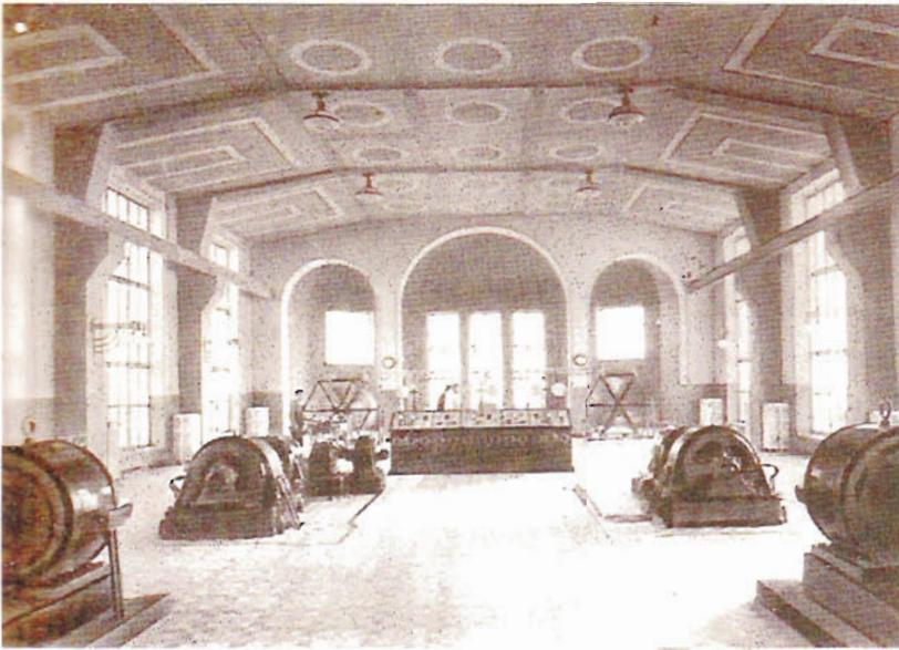
Figure 8. — Station de Prague, groupes HF de 50 kW (à gauche). Station de Bamako, groupes HF de 150 kW (ci-dessous).
