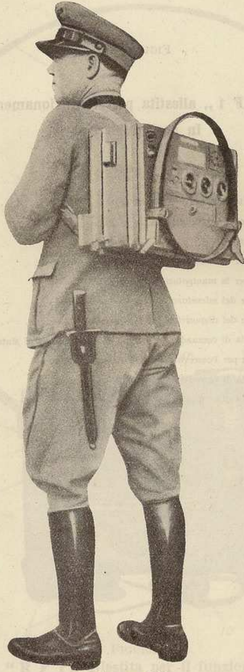
FIGURA VI. Trasporto a zaino della stazione " R F 1 ,,.
